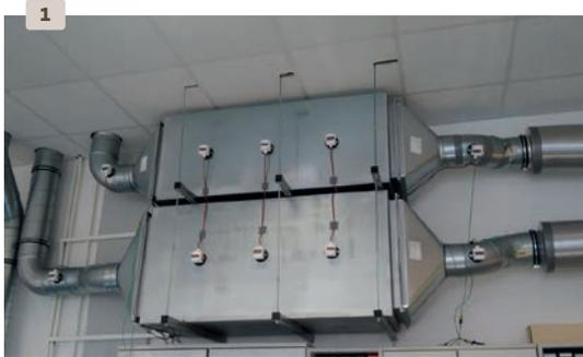
hohe Energieeffizienz ist hierbei immer, dass die zur Regeneration des PCM verwendete kühle Nachtluft nach Durchströmen des Speichers dem Raum zugeführt wird. So wird auch ihr verbleibendes Kühlpotenzial zur nächtlichen Raumauskühlung genutzt.
